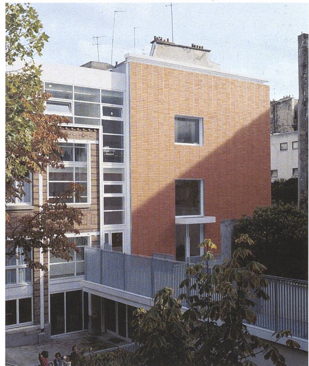
Schichten der Konstruktion. Schule Rue d'Oran, Paris Foto: Jean Marie Monthiers
