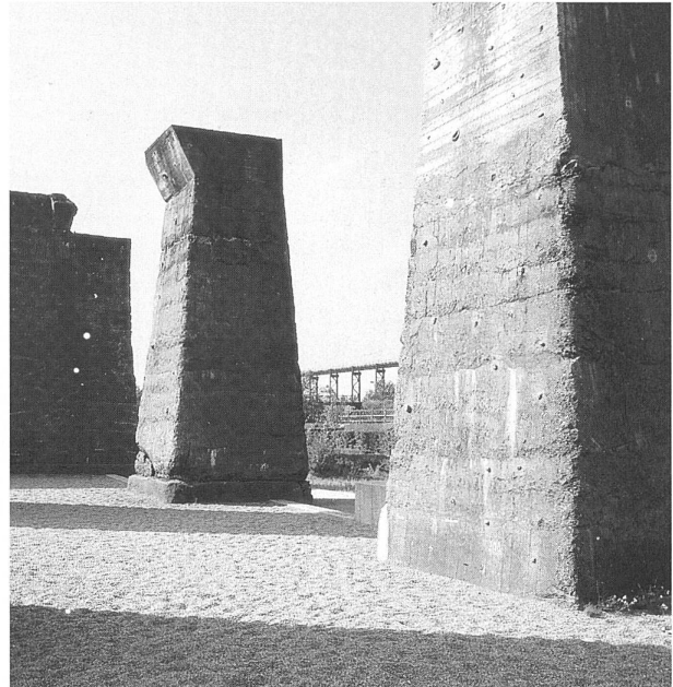
Säulenbasen der früheren Erzbunker, Klettergarten im Landschaftspark Duisburg-Nord
