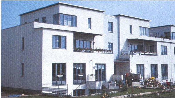
Siedlung im Ziegelgrund, Recklinghausen 100 Mietwohnungen und 70 Eigenheime/Eigentumswohnungen Thomas Kostulski, Köln Foto: T. Brenner
