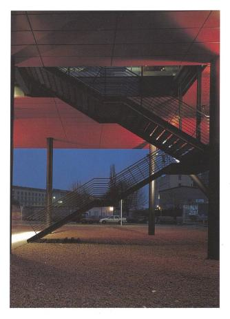
Volumen ohne Luftraum darunter beträgt somit 12.187.50 Kubikmeter. Die Erschließung des Gebäudes erfolgt über die 2.50 Meter breite Stahltreppe sowie einen Aufzug, die beide auf einer befestigten Ebene auf Geländeniveau beginnen. Unterhalb der Eingangsebene befindet sich der Hausanschlußraum des Gebäudes. Zwei offene Stahltreppen, die an beiden Längsseiten neben dem Gebäude stehen, dienen als notwendige Fluchttreppenhäuser.
