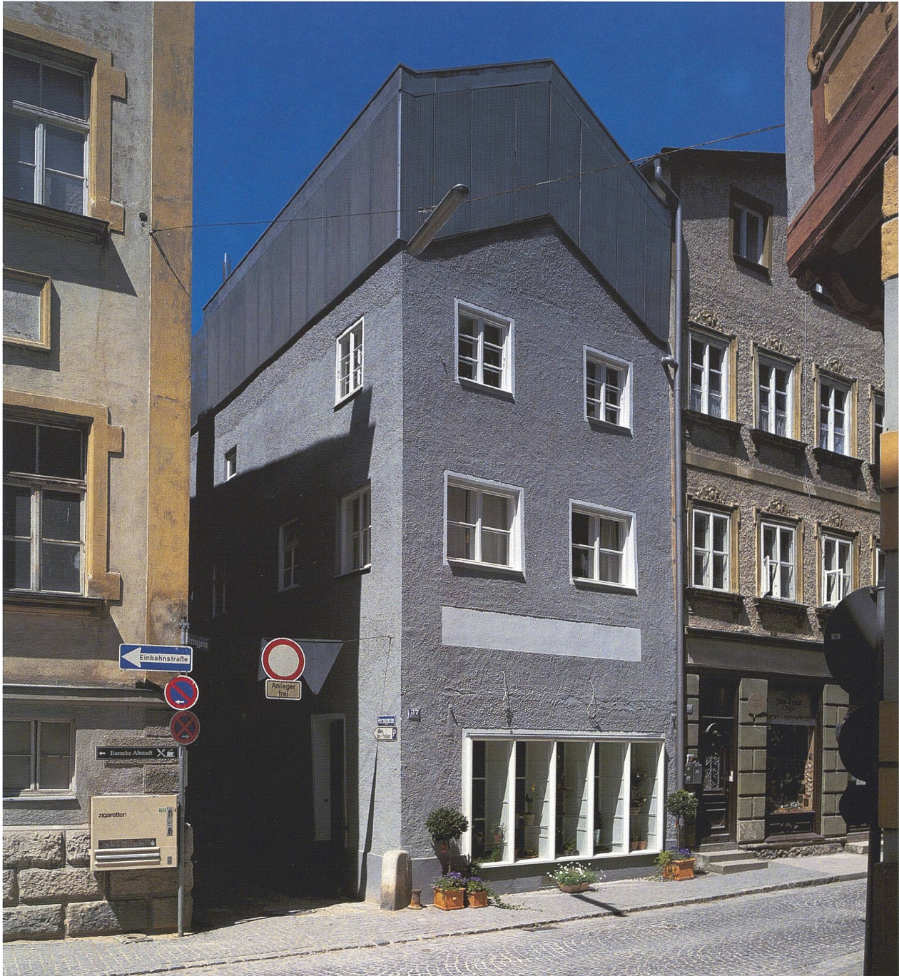
Andreas Hild, Tillmann Kaltwasser: Haus Bonnin, Eichstätt, 1995 Sanierung und Aufstockung, Ansicht und Details der Lochblechhaut Fotos: Michael Heinrich
