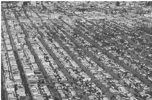
Los Angeles, Luftaufnahme der Stadtstruktur
