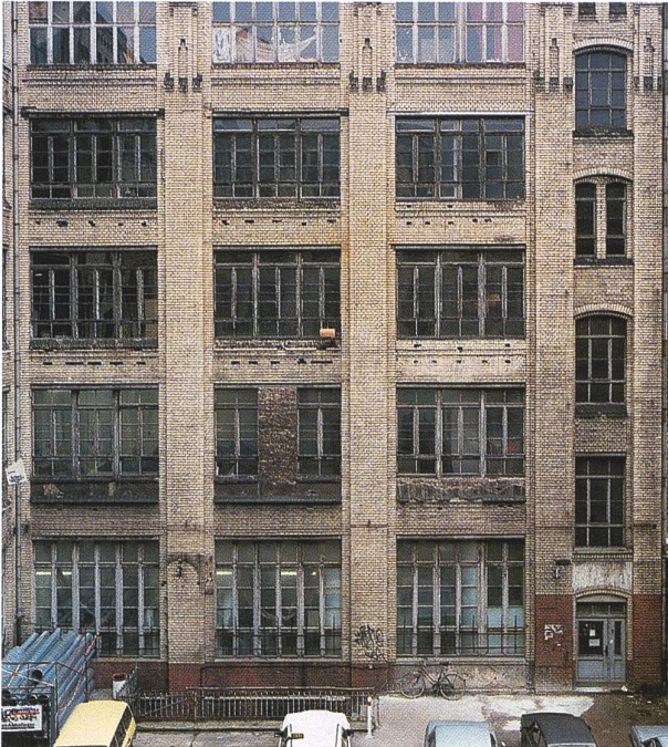
Zustand Mitte 1994 (Fotos: Wilmar Koenig)
