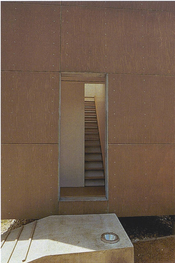
Eingangssituation mit Treppe ins 1. Obergeschoß
