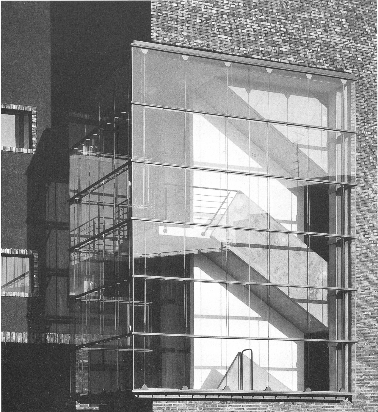
Gleichrichterwerk und Museumsdepot Frankfurt am Main 1990–1994. Architekt: Christoph Mäckler. Vorderansicht mit Glaserker (Ausschnitt) (Foto: Dieter Leistner)
