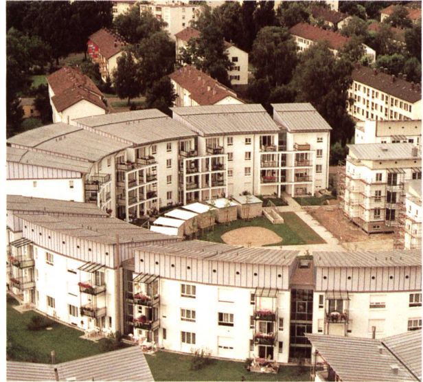
Lörrach, Wohnanlage „Stadion“ 220 Mietwohnungen im Geschößbau Entwurf und Planung: Wilhelm und Partner, Lörrach Barbara Wilhelm, Fritz Wilhelm
