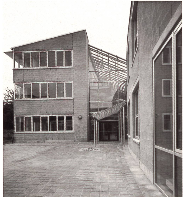
Eingangssituation von Westen
