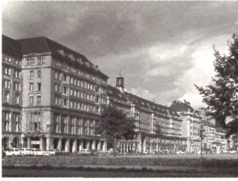
Dresden, Westseite des Altmarktes, gebaut 1953–1958
