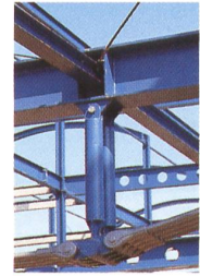
Fassade Hallentyp 2, Spritzgußverarbeitung Detail (Fotos: E. Schossig) Wegesystem (Foto: Jens Willebrand)
