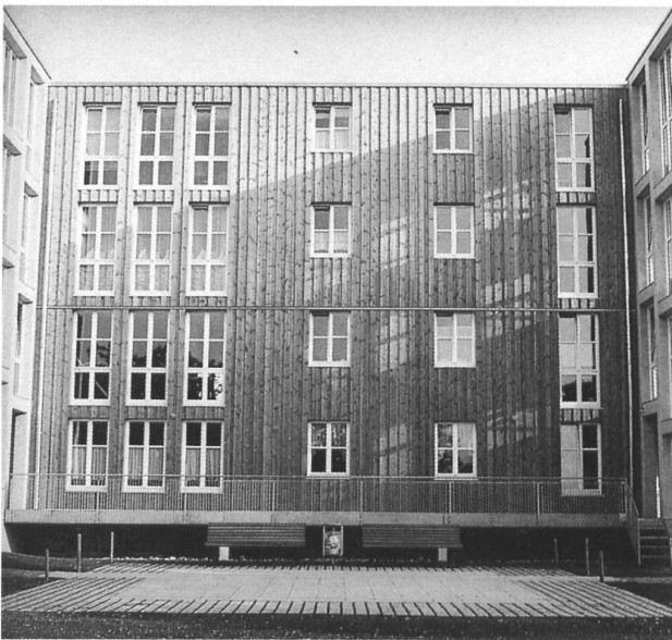
Detail Holzfassade mit Erschließungssteg (Fotos: Francesca Giovannelli, CH-Weiningen)
