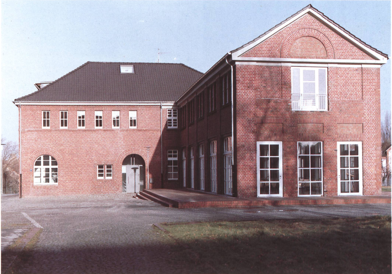
Bürogebäude der IBA Emscher Park in Gelsenkirchen Architekten: Heinrich Böll und Hans Krabel, Essen
