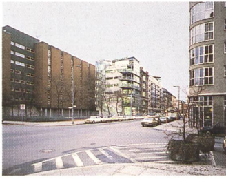
Alt- und Neubau des taz-Redaktionsgebäudes
