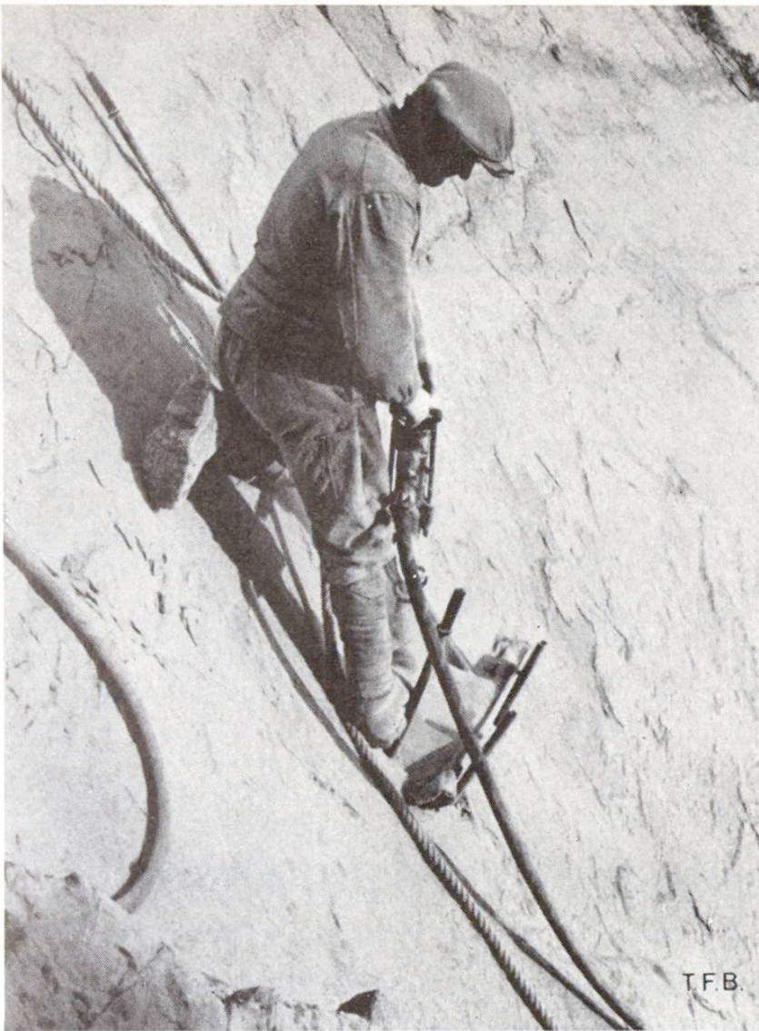
Abb. 1 Mineur beim Bohren an der Wand
