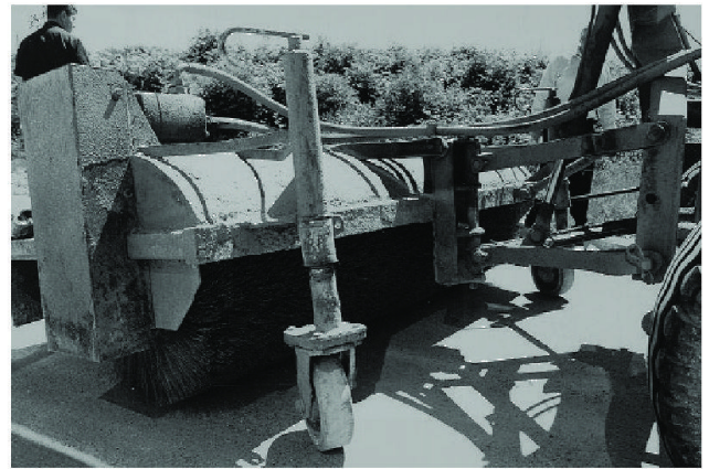
Abb. 9 Detail des zur Bürstmaschine umgebauten Graders, mit dem die lärmindernde Oberfläche hergestellt wird.
