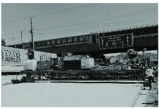
Abb. 7 Auch Engpässe können mit dem Gleitschalungsfertiger problemlos durchfahren werden.
