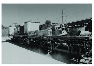
Abb. 6 Aufsprühen des Verzögerers am Schluss des Einbaus der zweischichtigen Betondecke.
