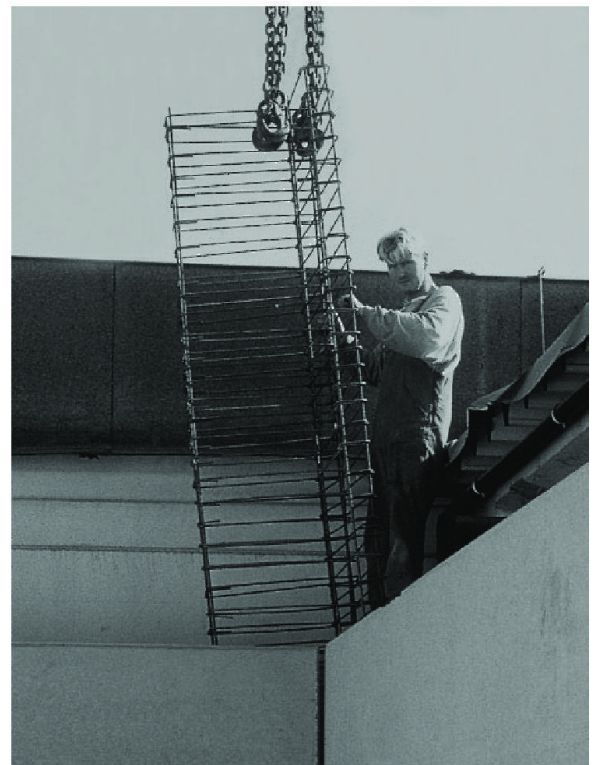
Abb. 9 Einsetzen des Bewehrungskorbs im Eckbereich der Dreifachwände.
