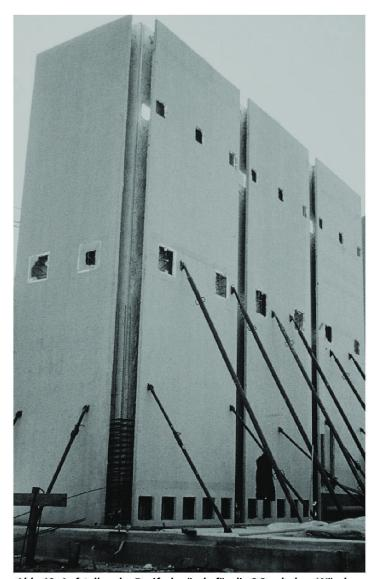
Abb. 10 Aufstellen der Dreifachwände für die 8,8 m hohen Wände eines Denitrifikationsbehälters. Foto: Funke, Frankfurt/Main
