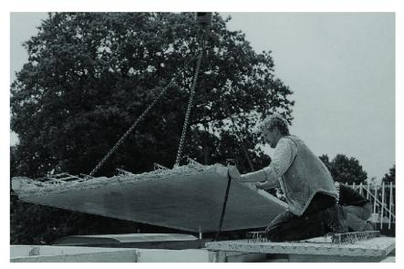
Abb. 1 Verlegen einer Elementdecke.
