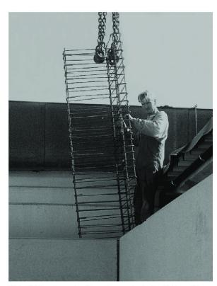
Abb. 9 Einsetzen des Bewehrungskorbs im Eckbereich der Dreifachwände. Foto: Ragano, Nordhorn
