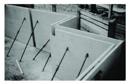
Abb. 5 Dreifachwand für Keller nach dem Aufstellen.
