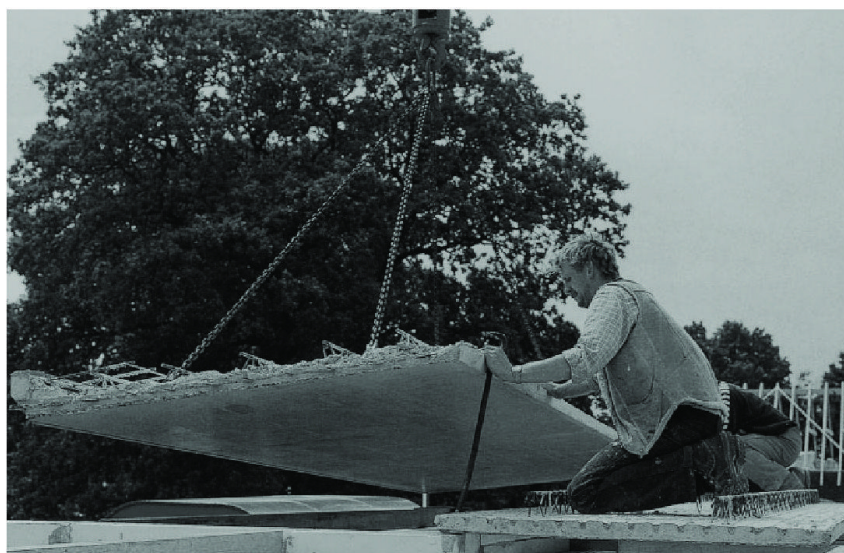
Abb. 1 Verlegen einer Elementdecke.
