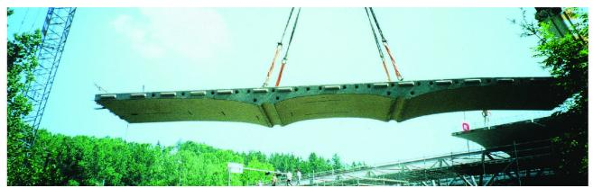
Abb. 2 Mit dem grössten Raupenkran der Schweiz wird eine der 61 vorfabrizierten Platten der neuen Talbrücke der A 1 in Dättwil versetzt. Diese sind 15,90 m lang, 3,20 m breit und an den dünnsten Stellen 0,25 m dick. Foto: TFB
