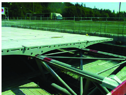
Abb. 1 In einem ersten Schritt wurden die vorfabrizierten Betonelemente auf dem Stahlfachwerkträger abgelegt.
