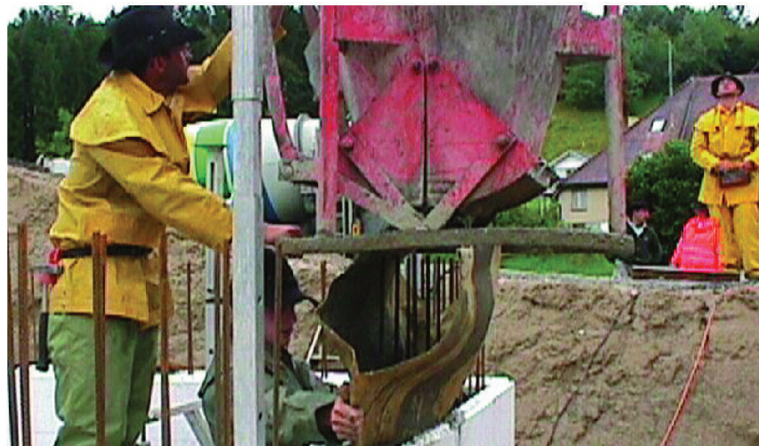
Betonieren eines Wandabschnitts mit selbstverdichtendem Beton (SCC).
