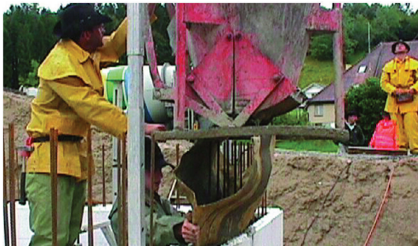
Betonieren eines Wandabschnitts mit selbstverdichtendem Beton (SCC).
