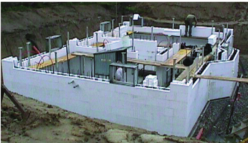
Aufbau der Schalung für das Kellergeschoss.
