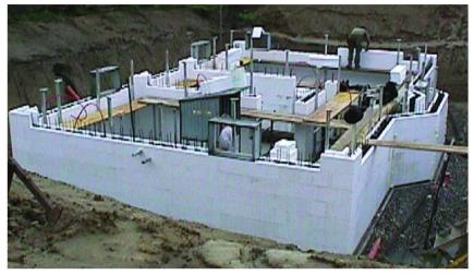
Aufbau der Schalung für das Kellergeschoss.
