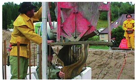
Betonieren eines Wandabschnitts mit selbstverdichtendem Beton (SCC).
