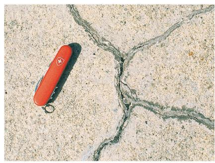
Abb. 6 AAR-Schaden in Krone von Staumauer. Die Risse enthalten (dunkles) Kieselgel.
