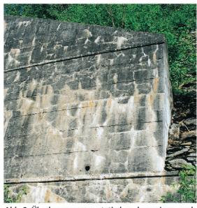
Abb. 2 Überlagerung von statischen, korrosions- und AAR-bedingten Rissen mit Kalkablagerungen.
