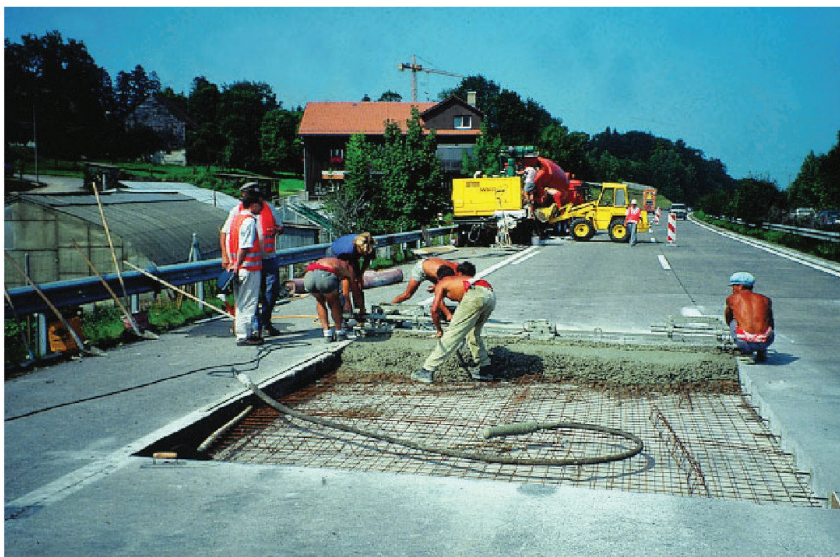
Abb. 5 Plattenersatz unter Verwendung von frühfestem Beton in der Schweiz.
