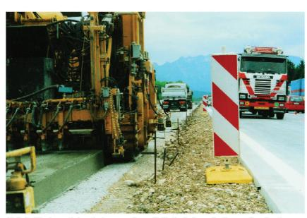
Abb. 3 Moderne Betondecken werden mit Gleitschalungsfertigern eingebaut.
