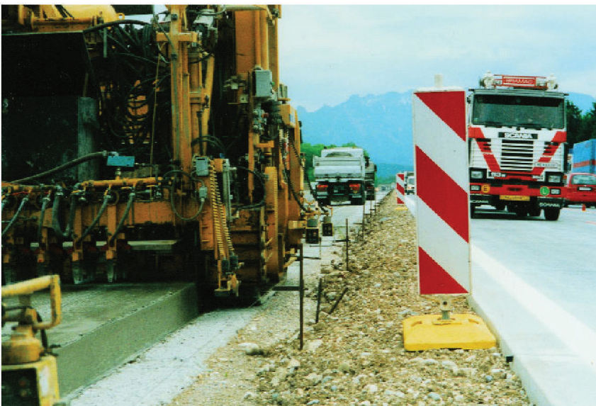
Abb. 3 Moderne Betondecken werden mit Gleitschalungsfertigern eingebaut.
