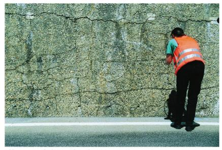
Abb. 3 AAR-Schäden in unbewehrter Stützmauer.
