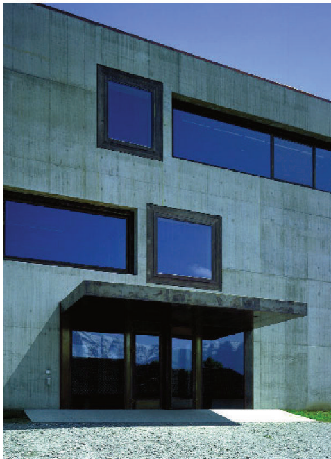
Eingangsfassade des Schulhauses in Paspels.
