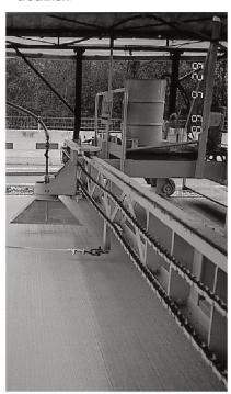
Behandlung mit Curing compound direkt im Anschluss an den Betoneinbau mit Fertiger. Foto: TFB-Archiv
