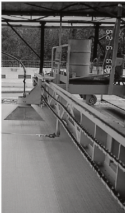
Behandlung mit Curing compound direkt im Anschluss an den Betoneinbau mit Fertiger.
