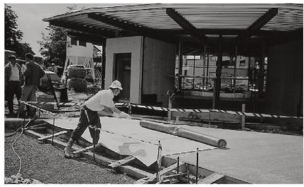
Abdecken eines frisch eingebauten Betonbelags mit Thermomatten.
