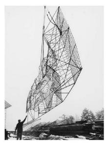
Abb. 3 Transport eines vorgefertigten Skelettteils. Foto: Jürg Buess, Basel
