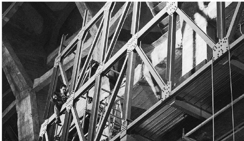
Abb. 4 Montage der Tragkonstruktion.
