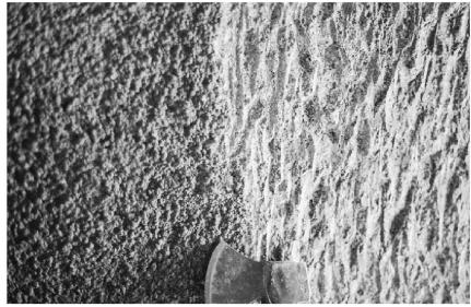
Abb. 10 Spritzbetonoberfläche, spritzrau (links) und nach dem Behauen.
