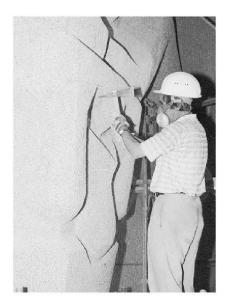
Abb. 11 Feinbearbeitung der Spritzbetonoberfläche durch einen Bildhauer.
