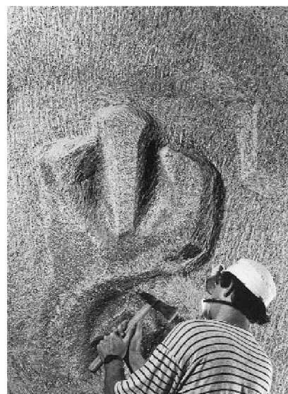
Abb. 9 Behauen des Spritzbetons mit dem Beil. Foto: Jürg Buess, Basel
