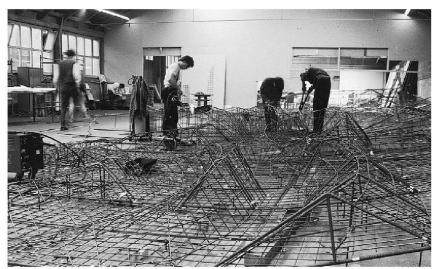
Abb. 2 Vorfertigung des Rundstahlskeletts.
