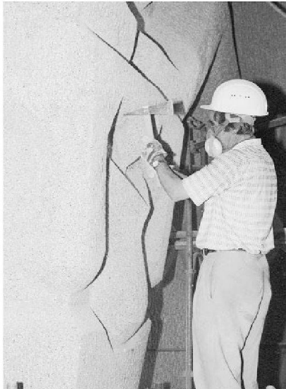
Abb. 11 Feinbearbeitung der Spritzbetonoberfläche durch einen Bildhauer.
