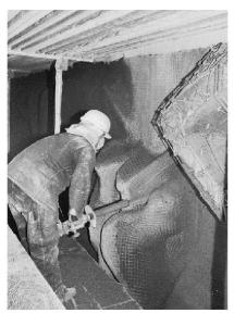
Abb. 7 Der Spritzbeton wird aufgetragen. Foto: Laich SA, Avegno
