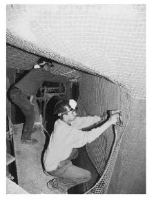
Abb. 8 Befestigung des Glasfasernetzes. Foto: Laich SA, Avegno
