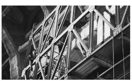
Abb. 4 Montage der Tragkonstruktion.
