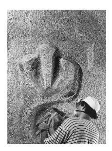
Abb. 9 Behauen des Spitzbetons mit dem Beil. Foto: Jürg Buess, Basel
