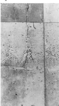
Wasserausscheidung im Bereich einer Betonierfuge. Foto: TFB-Archiv
