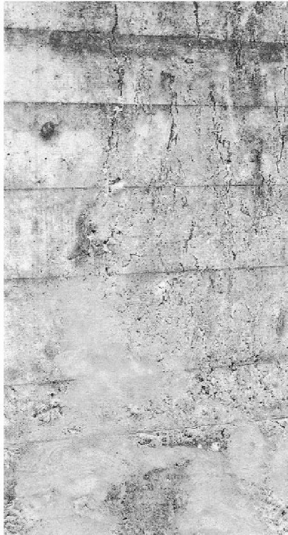
Wasserausscheidung aus einem Kiesnest.
