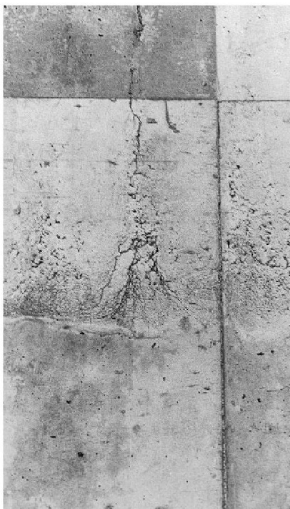
Wasserausscheidung im Bereich einer Betonierfuge.
