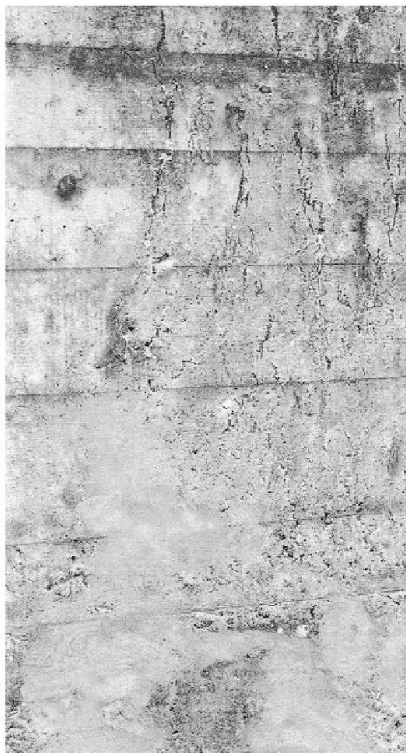
Wasserausscheidung aus einem Kiesnest.
