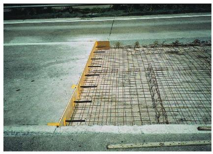
Plattenersatz: zum Betonieren vorbereitet.
