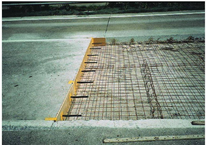
Plattenersatz: zum Betonieren vorbereitet.
