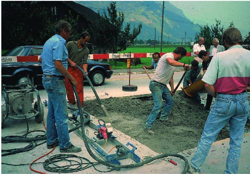
Einbau von frühfestem Beton
