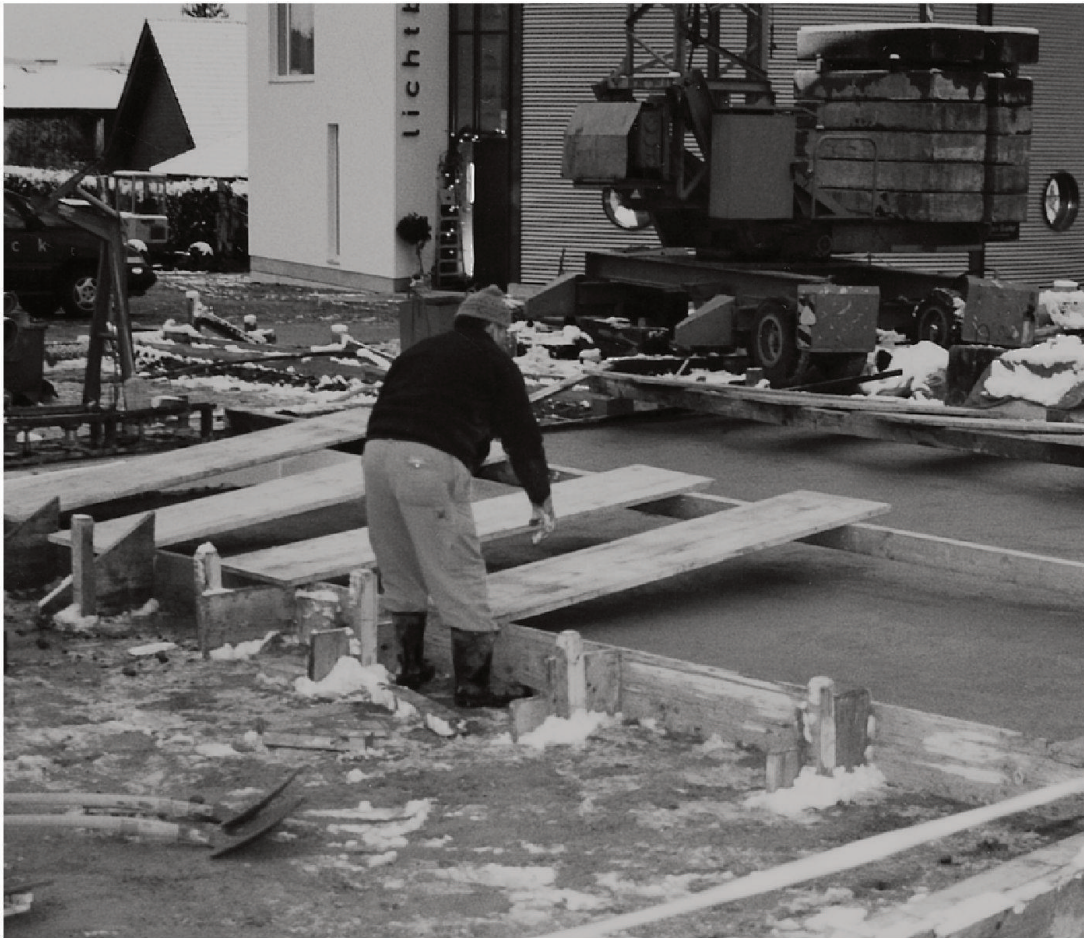
Vorbereitung der Isolation einer frisch betonierten Bodenplatte.
