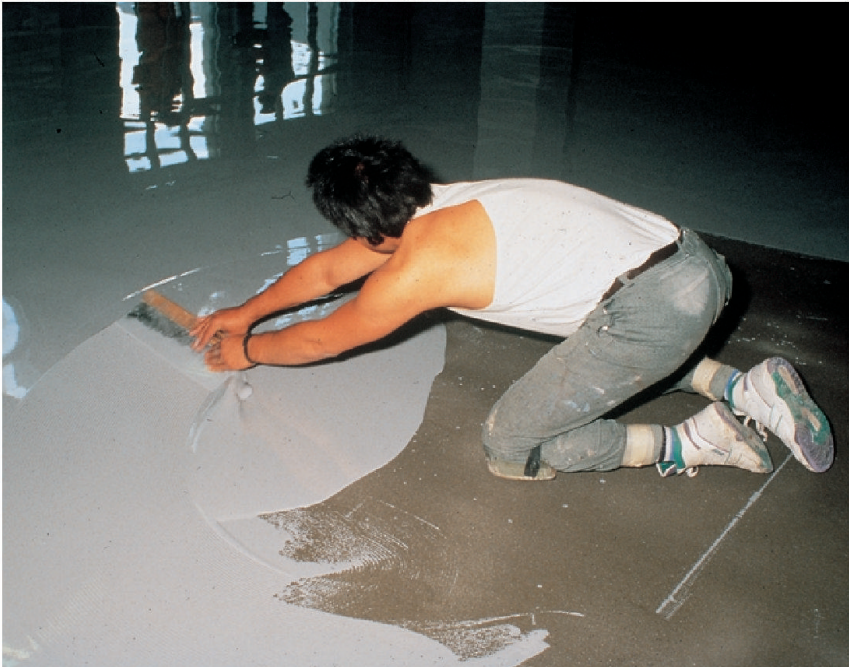
Auftragen eines rissüberbrückenden Fließbelags mittels einer Zahntraufel.
