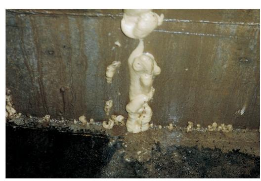
Wasserstop durch PUR-Injektion.
