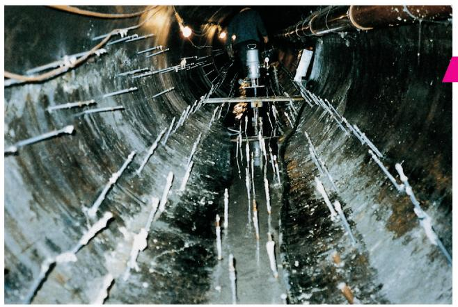
Im Boden-/Sohlenbereich einer Betonkanalisation gesetzte Packer.
