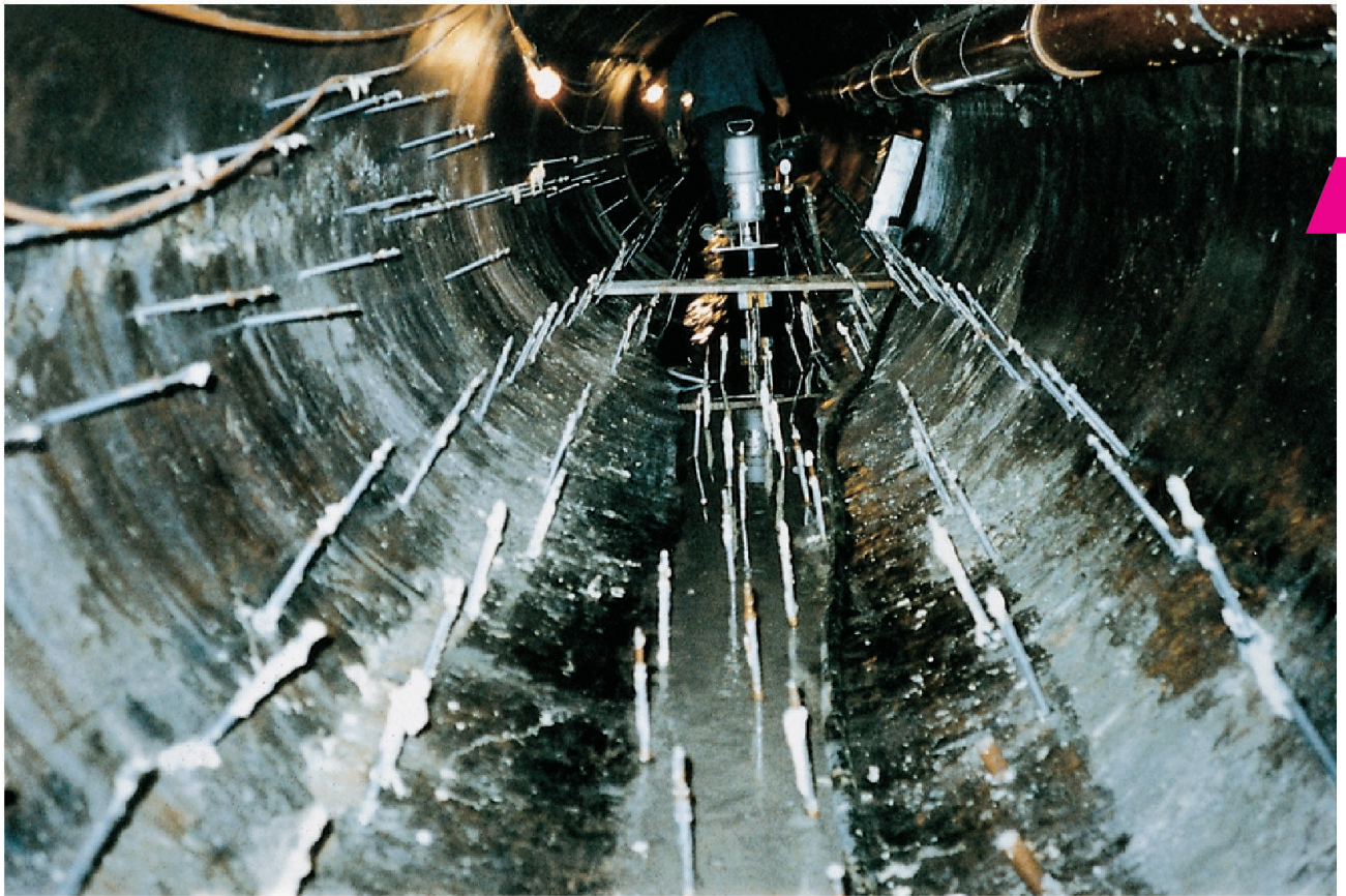
Im Boden-/Sohlenbereich einer Betonkanalisation gesetzte Packer.
