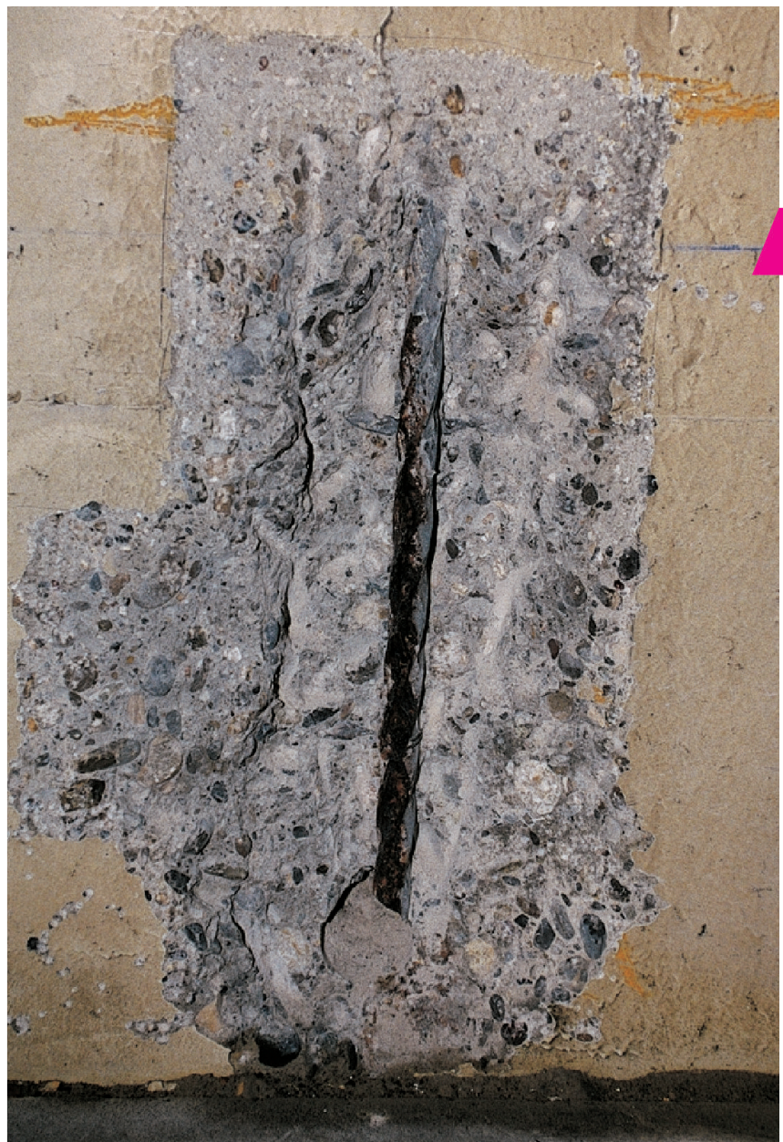
Das Bewehrungsstange ist auf der Risseite korrodiert.
