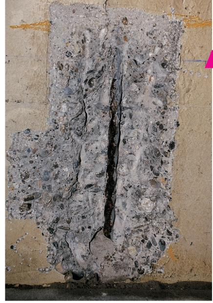
Das Bewehrungseisen ist auf der Rissseite korrodiert.
