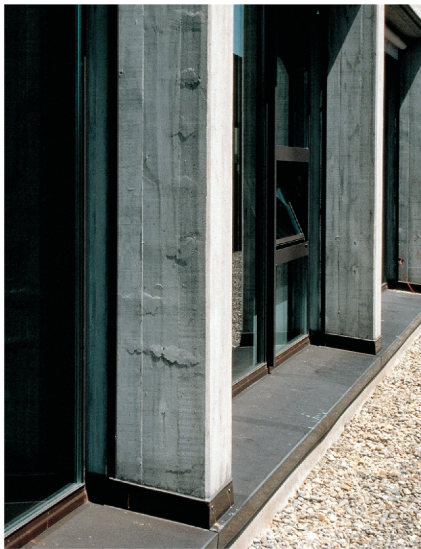
Korrosionsschäden an Stützen.
