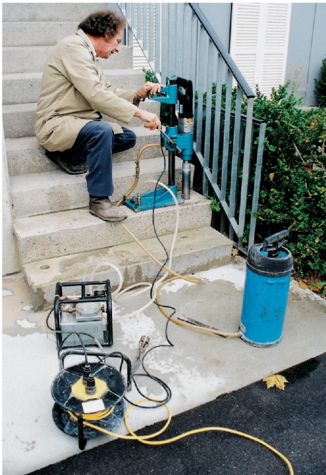
Bohrkernentnahme als Teil einer zerstörenden Untersuchung.
