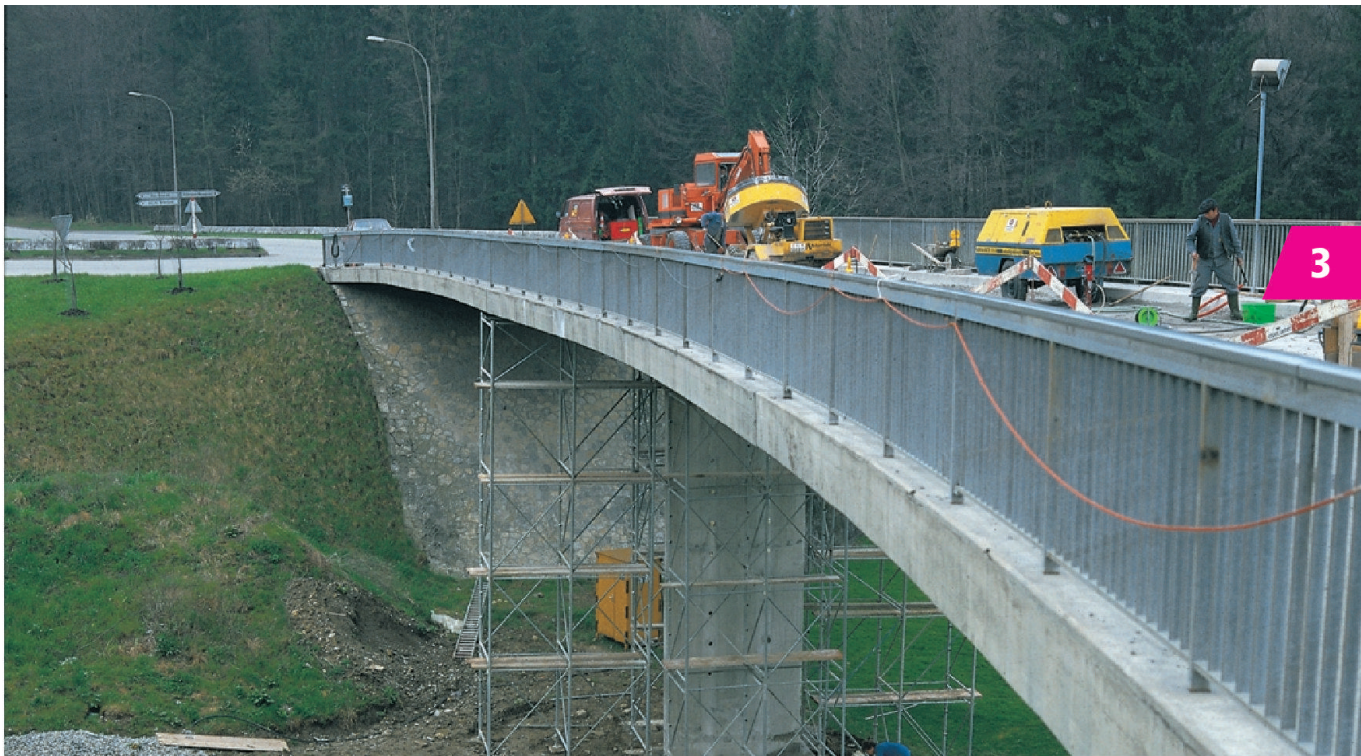
Sanierung einer Betonbrücke.
