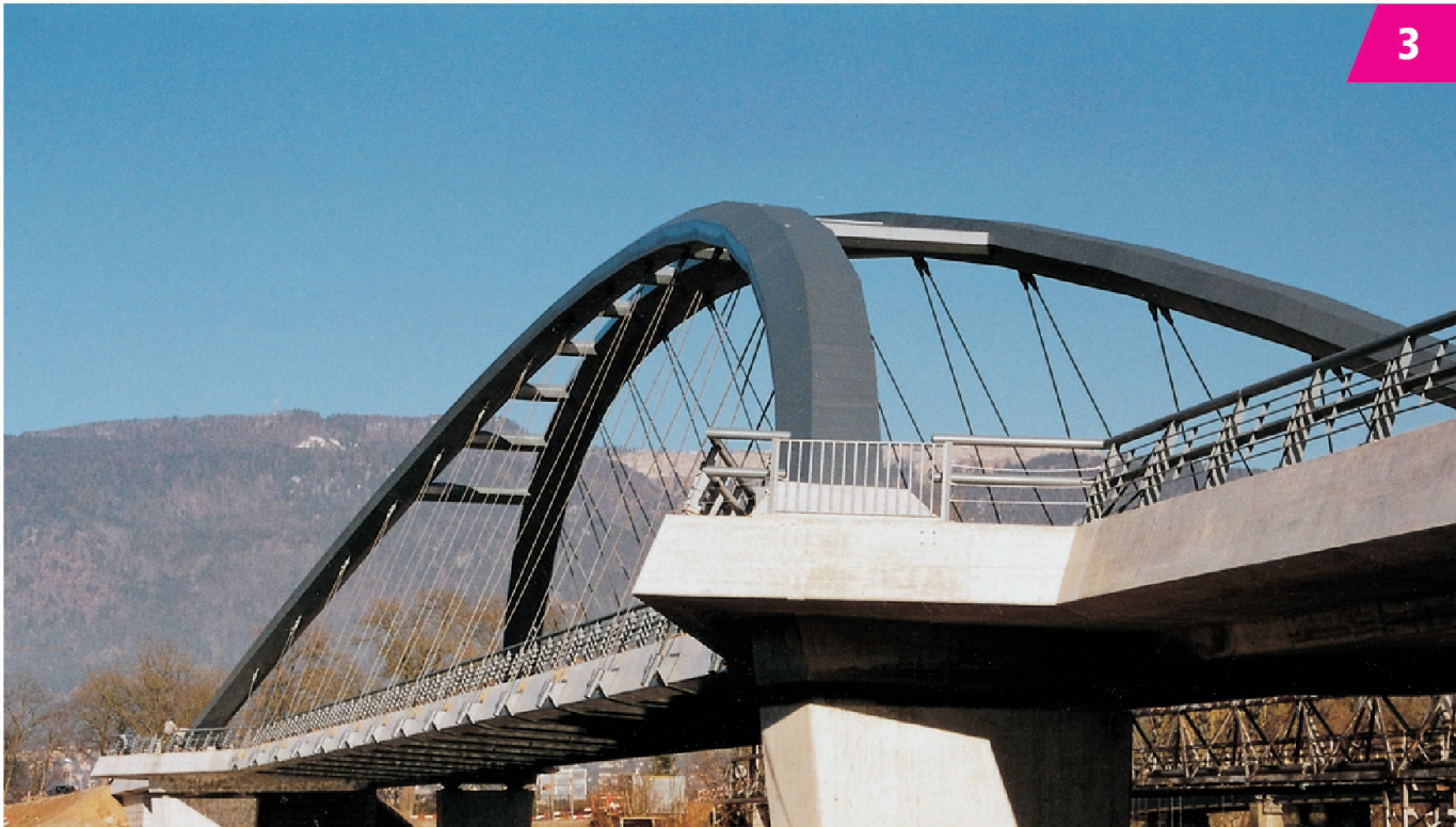
Aarebrücke bei Arch (A 5).
