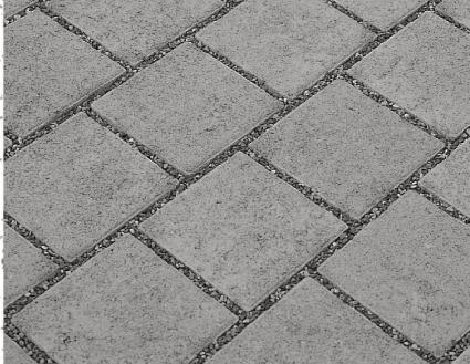
Wasserdurchlässiger Pflasterbelag mit Splittfugen.
