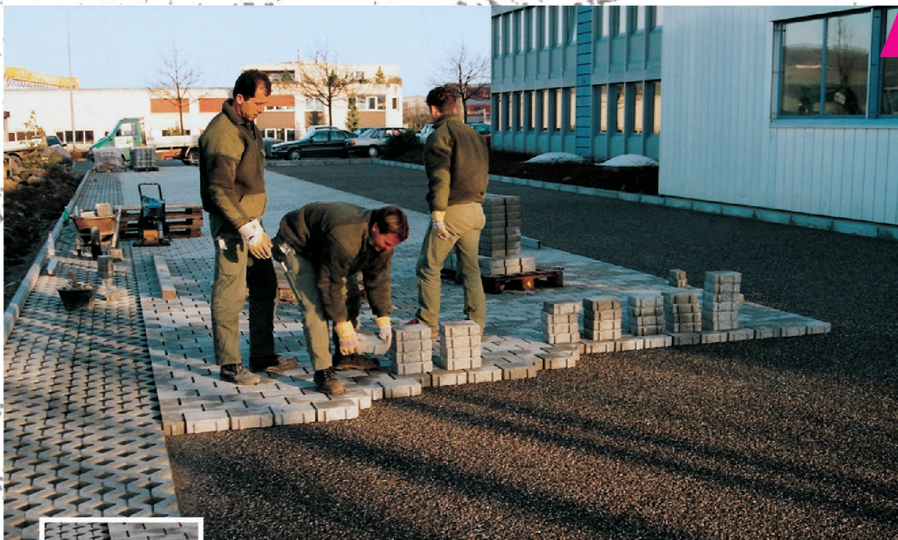
Handverlegung von Betonpflastersteinen.
