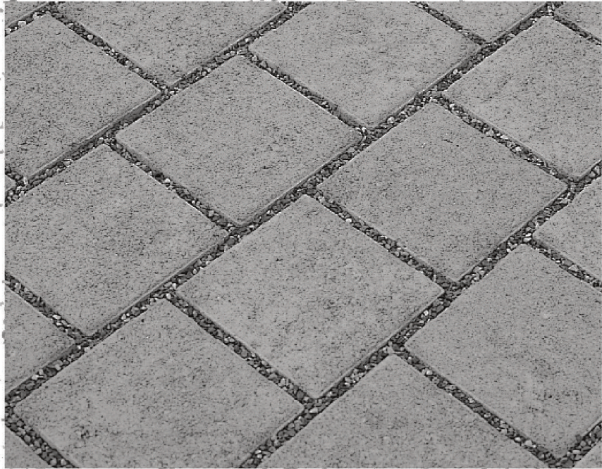
Wasserdurchlässiger Pflasterbelag mit Splittfugen.
