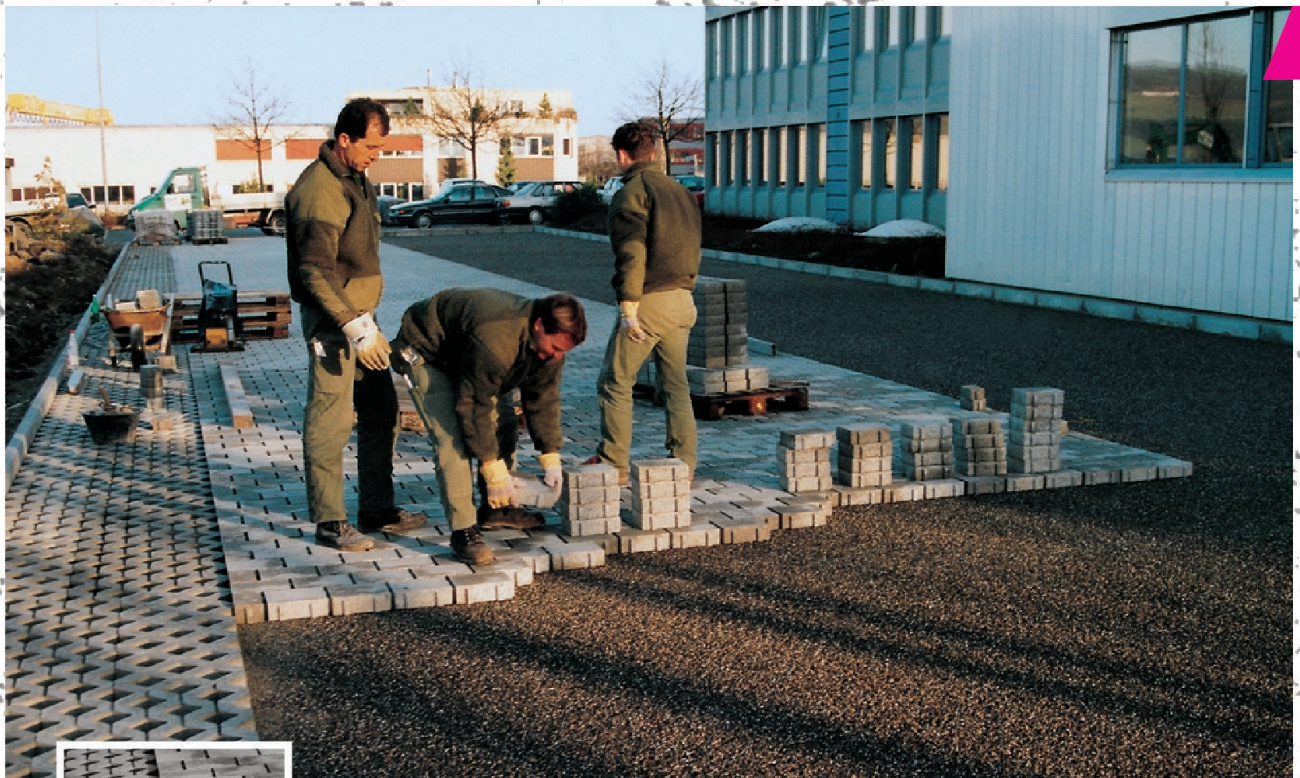
Handverlegung von Betonpflastersteinen.
