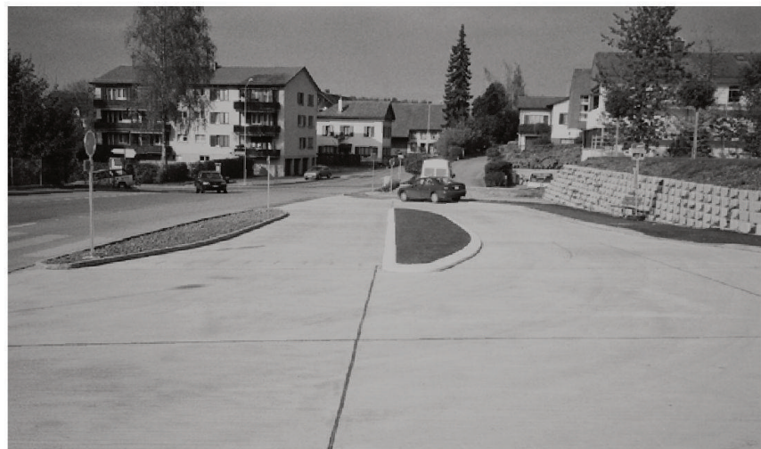
Neue Bushaltestelle in Stetten AG.
