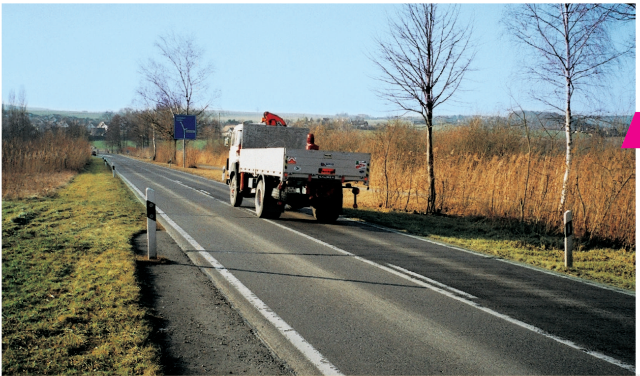
Kantonsstrasse Oberhöri-Dielsdorf (Neeracher Riedt). Die 1951 erstellte Strasse durchquert das Ried. Sie hebt und senkt sich je nach Höhe des Grundwasserspiegels um 1 bis 4 cm pro Jahr; Grundwasserstand: unterkant Betonbelag!
