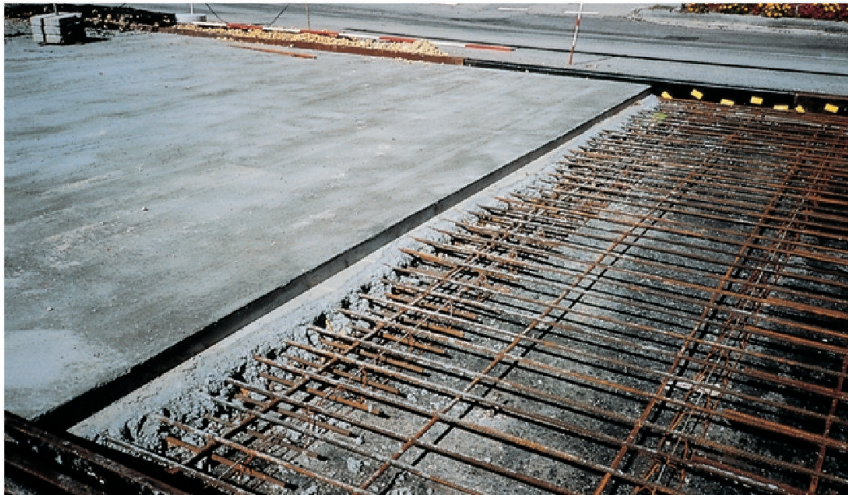
Arbeitsfuge eines durchgehend bewehrten Betonbelags (Le Locle, 1988).
