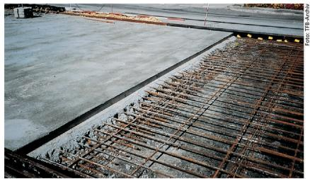
Arbeitsfuge eines durchgehend bewehrten Betonbelags (Le Locle, 1988).
