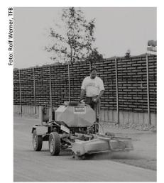
Erstellen der lärmmindernden Waschbetonoberfläche durch maschinelles Ausbürsten.
