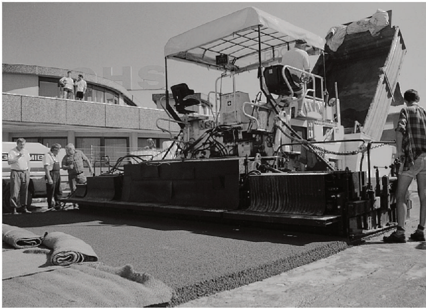
Einbau von Drainbeton.
