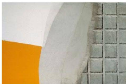
Schutzbeschichtung als Teil einer Reprofilierung: Haftschräume, Reprofiliermörtel, Flächenspachtel und Beschichtung.
