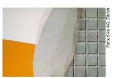
Schutzbeschichtung als Teil einer Reprofilierung: Haftschlämme, Reprofiliermörtel, Flächenspachtel und Beschichtung.
