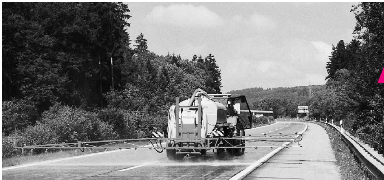
Hydrophobierung einer Betonfahrbahn.
