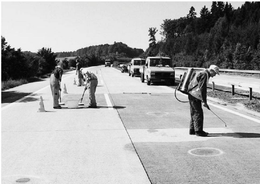
Vorversuche für die Hydrophobierung einer Betonfahrbahn: Auftragen des Imprägnierungsmittels durch Spritzen bzw. Rollen.
