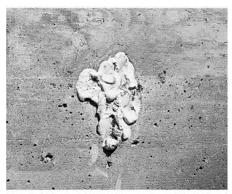
Abb. 10 Eingetrocknete Adsorptionspaste.
