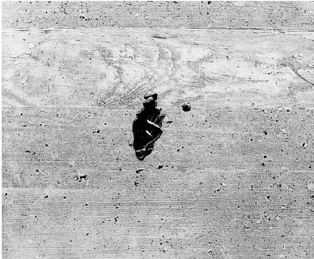
Abb. 1 Durch Bitumen verunreinigte Betonoberfläche.
