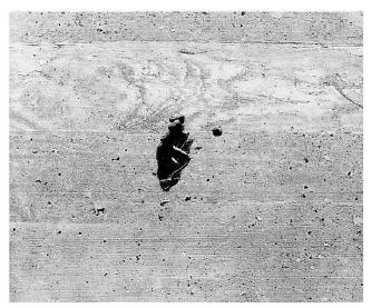
Abb. 1 Durch Bitumen verunreinigte Betonoberfläche.
