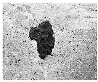
Abb. 8 Die Adsorptionspaste wird erneut aufgetragen.
