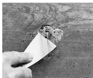
Abb. 6 Die eingetrocknete Adsorptionspaste wird entfernt.
