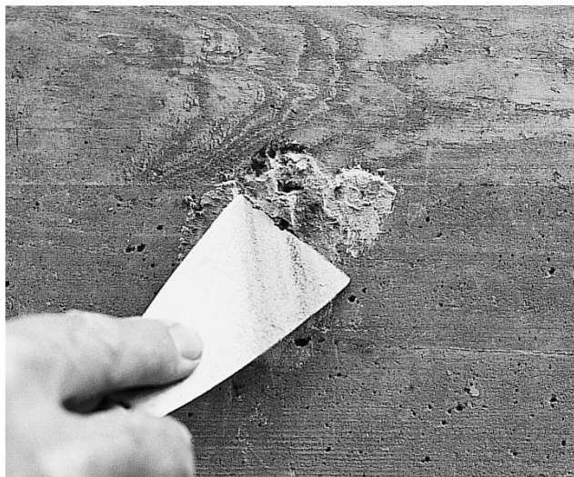
Abb. 6 Die eingetrocknete Adsorptionspaste wird entfernt.
