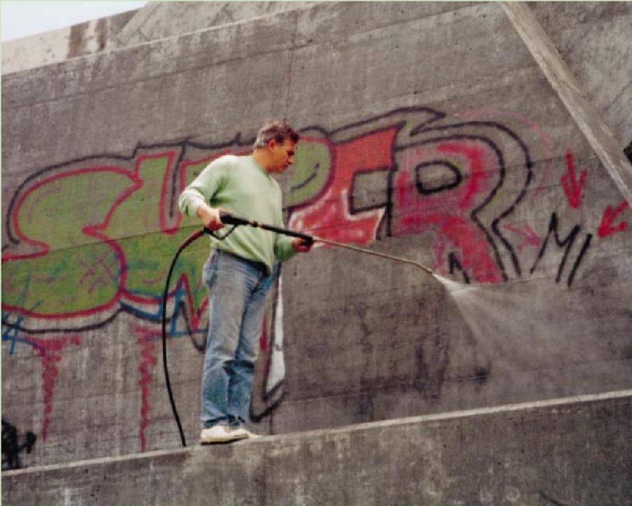
Entfernung von Graffiti auf Sichtbeton, der mit einer Imprägnierung und einer Wachsschicht (Opferschicht) vorbehandelt war.
