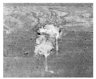
Abb. 5 Die Adsorptionspaste ist eingetrocknet.
