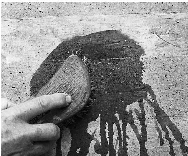
Abb. 11 Die Adsorptionspaste wird entfernt, am Schluss mit Bürste und Seifenwasser waschen.
