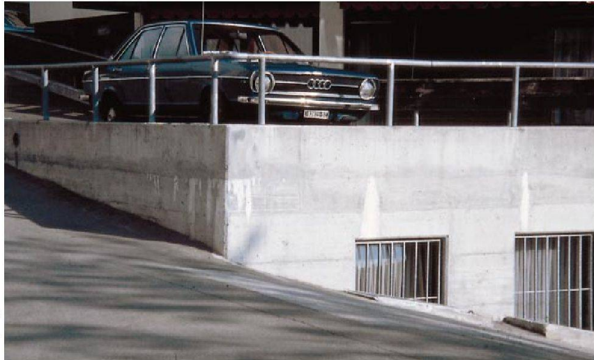
Sichtbetonwände mit Kalk- ausblühungen.
