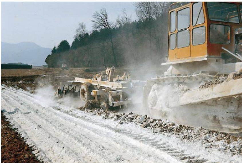
Einfräsen von Weissfeinkalk mit Scheibenegge.
