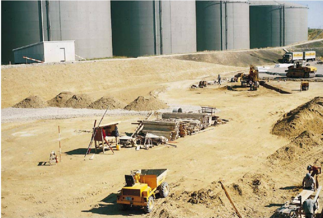
Bau von kalkstabilisiertem Auffangbassin für Tanklager.
