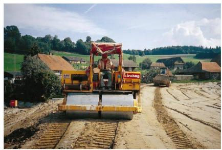
Verdichten von kalkstabilisiertem Boden mit Vibrationswalze.
