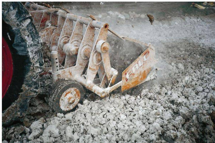
Einmischen von Weissfeinkalk mit Bodenfräse.
