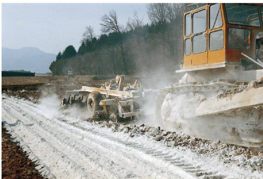
Einfräsen von Weissfeinkalk mit Scheibenegge.
