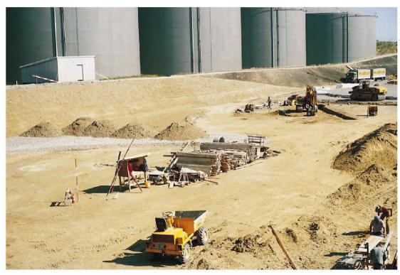
Bau von kalkstabilisiertem Auffangbassin für Tanklager.
