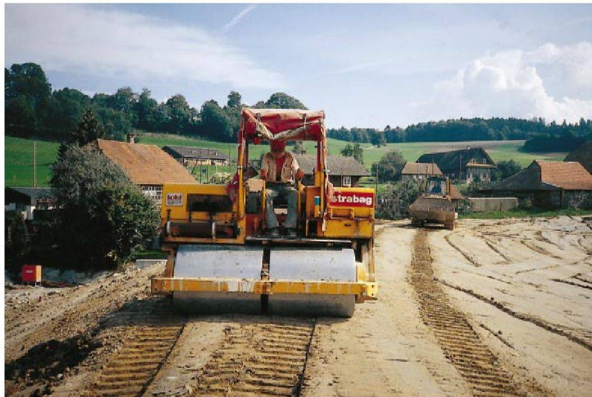
Verdichten von kalkstabilisiertem Boden mit Vibrationswalze.
