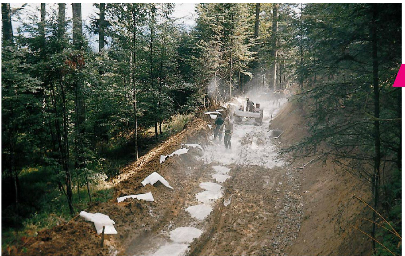
Kalkstabilisierung im Waldstrassenbau.
