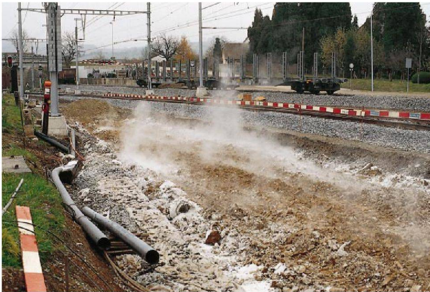
Wasser verdampft nach dem Einmischen von Weissfeinkalk (Sofortreaktion).
