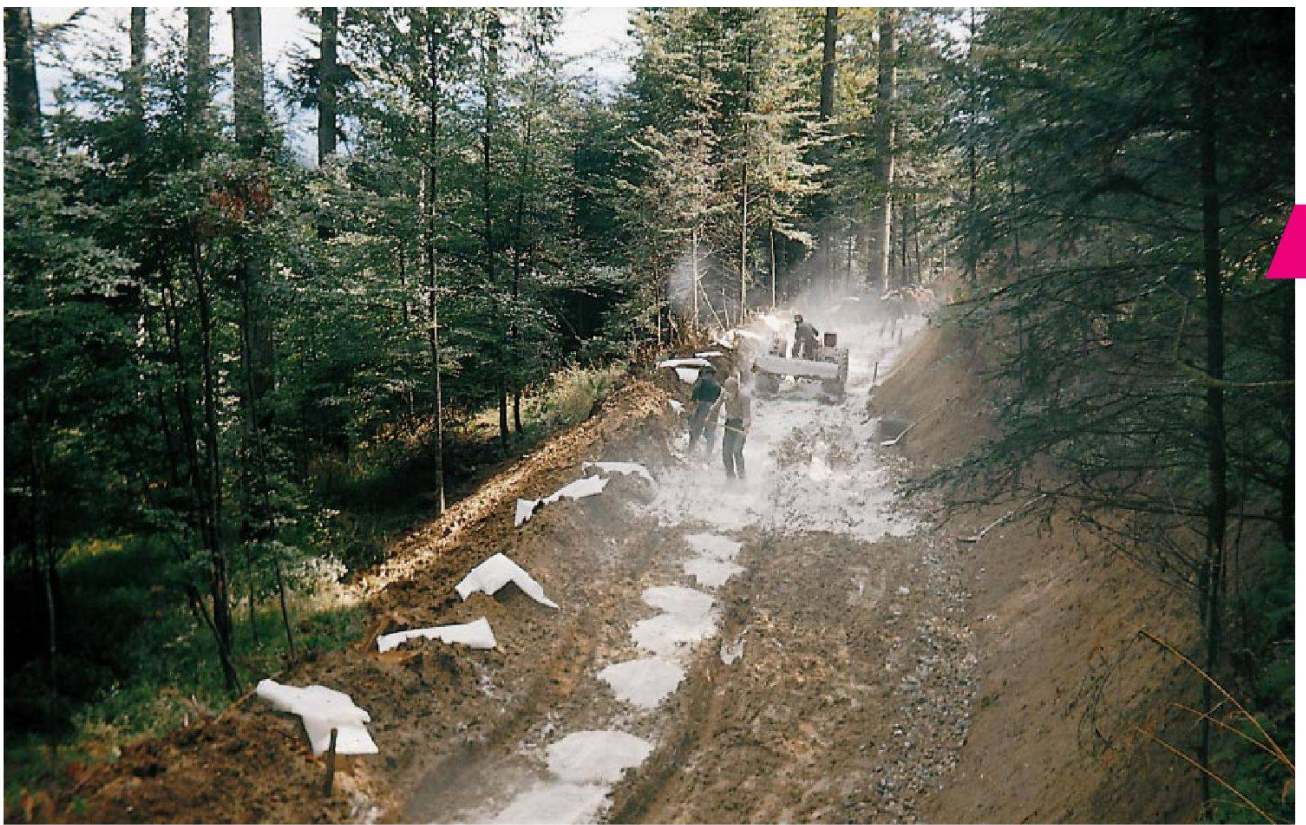
Kalkstabilisierung im Waldstrassenbau.
