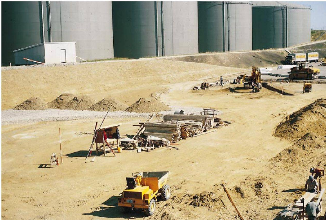
Bau von kalkstabilisiertem Auffangbassin für Tanklager.
