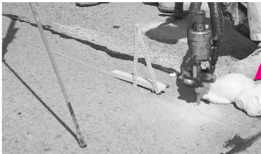
Vorbereitung zum Heben einer Platte durch Unterpressen (Kantonsstrasse im Tessin).
