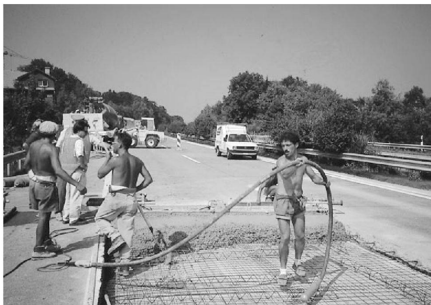
Teilersatz einer Betonplatte (A1).
