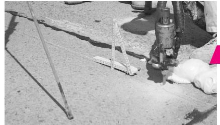
Vorbereitung zum Heben einer Platte durch Unterpressen (Kantonsstrasse im Tessin).
