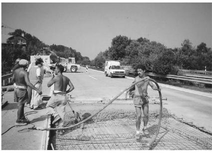
Teilersatz einer Betonplatte (A1).
