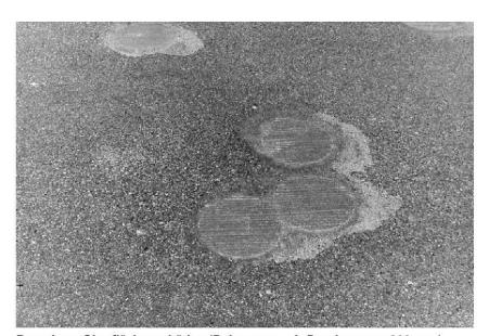
Reparierte Oberflächenschäden (Bohrungen mit Durchmesser 300 mm) auf der A8.
