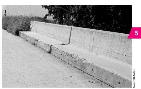
Frosttausalzschäden (Abplatzungen) auf Brückenbrüstung.
