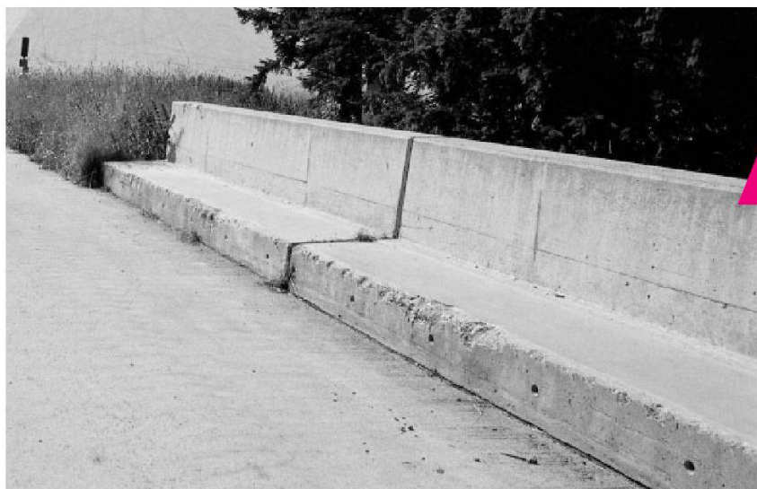
Frosttausalzschäden (Abplatzungen) auf Brückenbrüstung.
