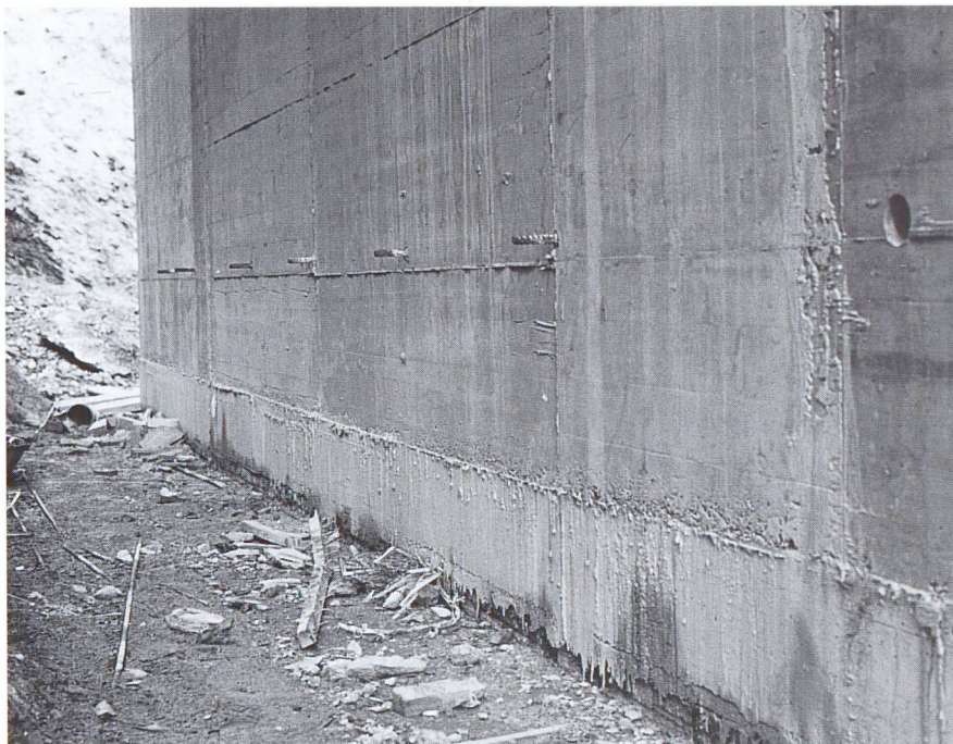
Wandstück aus Schwerbeton (hinten) und Normalbeton (Strahlenschutz-bunker für zwei Linearbeschleuniger, Kantonsspital Luzern) [9].
