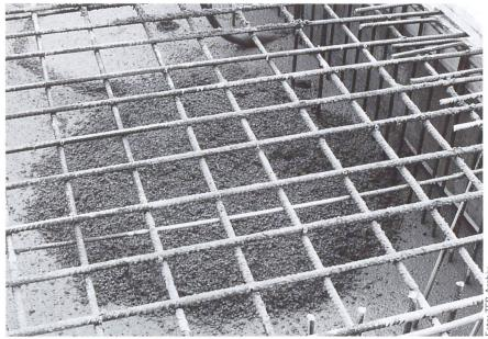
Einbau von Strahlenschutz-Frischbeton mit Baryt als Schwerzuschlag.
