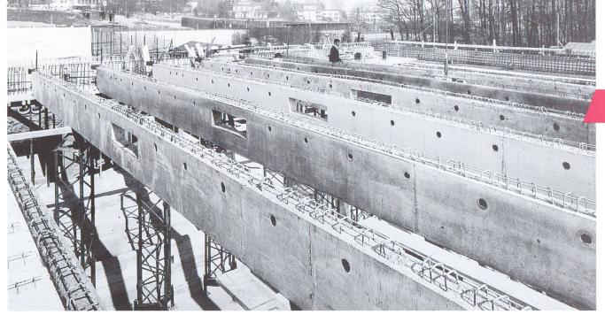
24 m lange vorfabrizierte Deckenträger aus LB 35/25 der Rohdichte 1,8 kg/m<sup>3</sup>.
