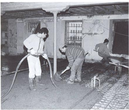
Altbausanierung mittels Holz-Beton-Verbundsystem (Leichtbeton LB 20/10, Rohdichte 1,5 kg/m³).
