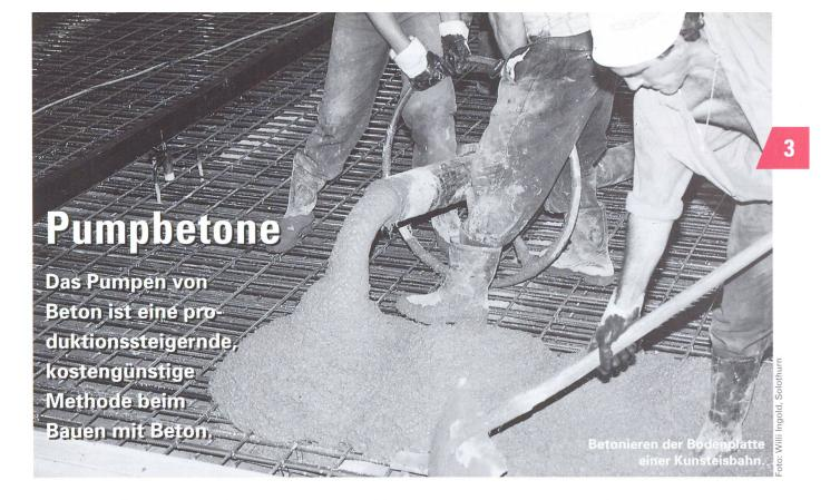
Auf Baustellen muss der Beton vom Mischer oder vom Transportfahrzeug aus möglichst schnell und unverändert zur Einbaustelle gelangen: Er soll sich nicht entmischen sowie weder austrocknen noch verwässert und weder zu stark erwärmt noch zu stark abgekühlt werden. Dies wird meistens auf eine der folgenden Arten geschehen:
