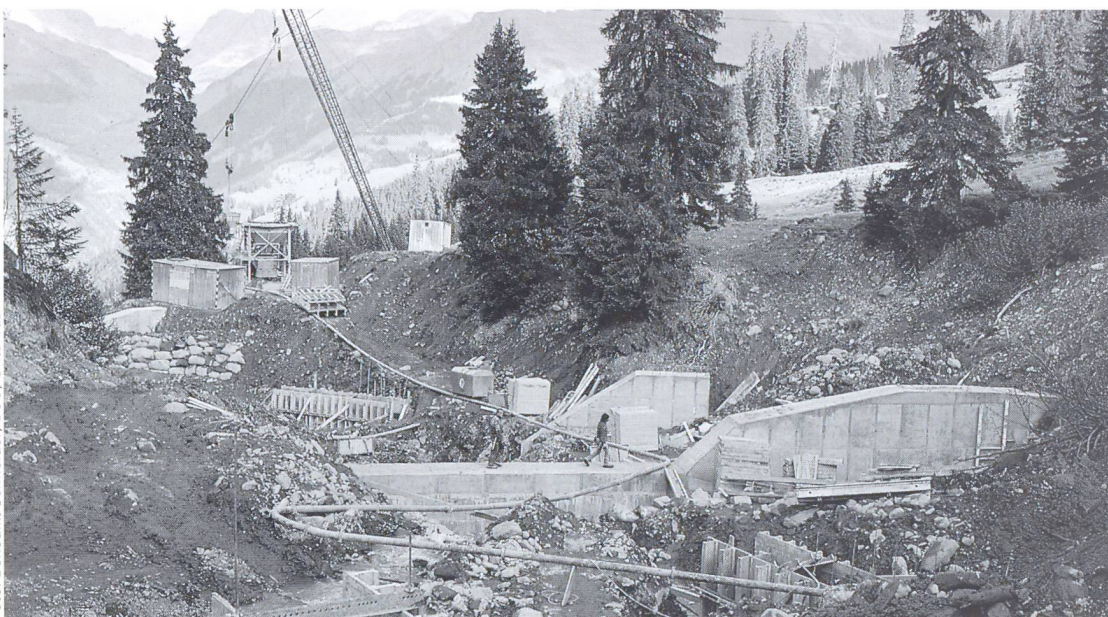
Bachverbauung: Pumpbeton- förderung in un- wegsamem Gelände.
