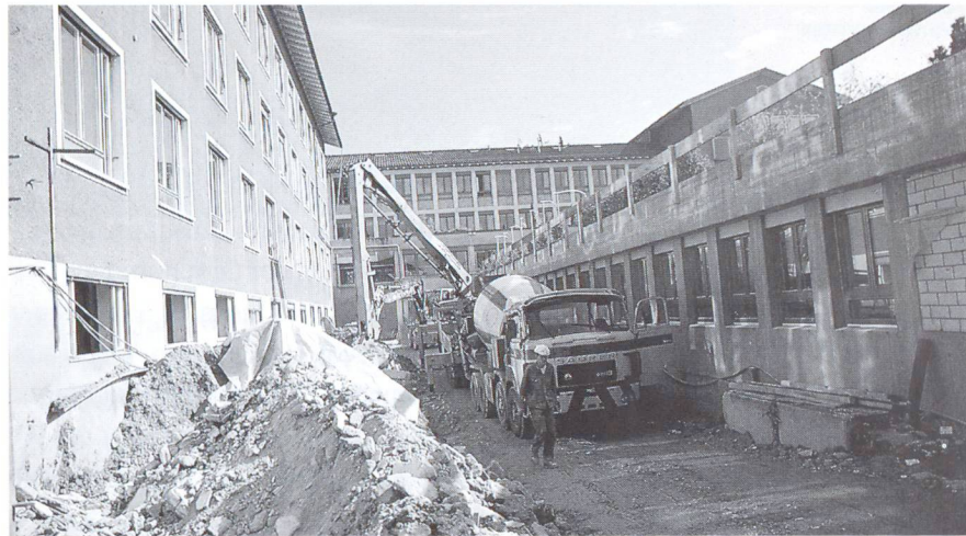
Betonpumpeneinsatz an schwer zugänglicher Stelle.
