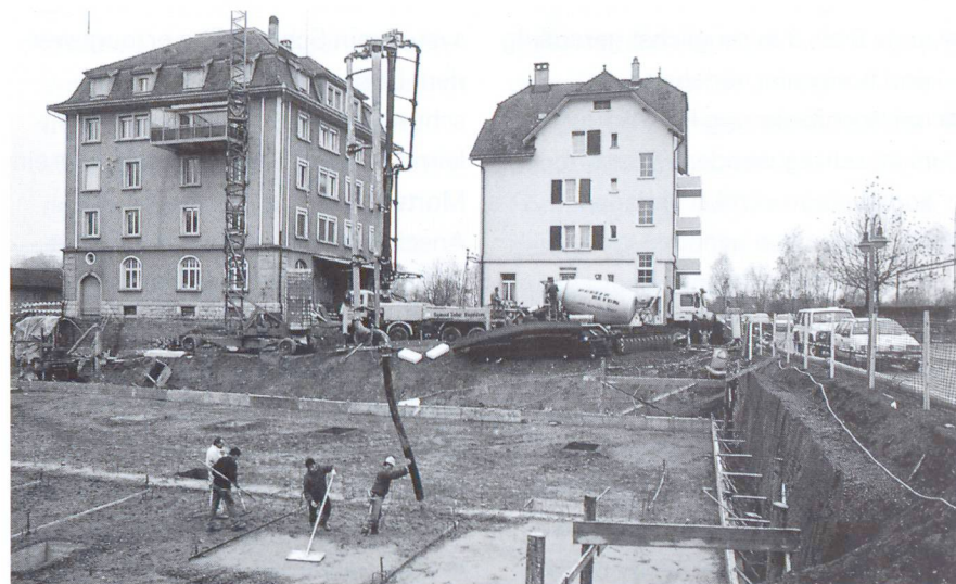
Einbau einer Sauberkeitsschicht (150 kg CEM I, hoher Sandanteil und Pumphilfe) mittels einer Autobetonpumpe.
